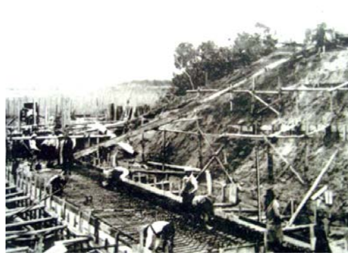
占部用水天白樋門工事 大正10年
