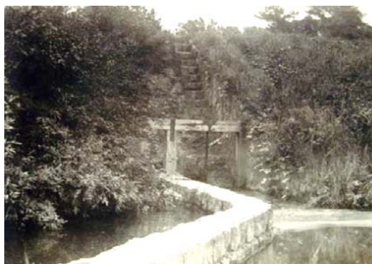
占部用水天白樋門 大正10年
