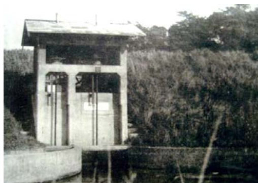
占部用水天白樋門 大正10年
