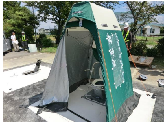
【災害用トイレ（左：和式 右テント洋式）】
