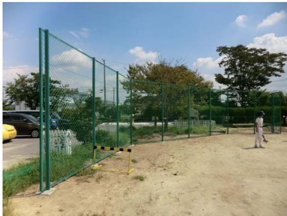
【駐車場前の新フェンス】
