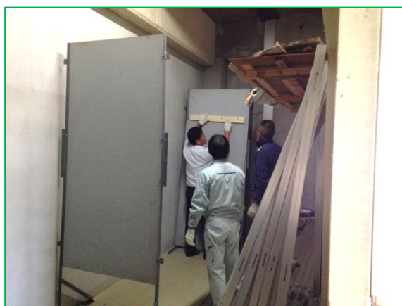
【北舎2F「物入れ」部屋の作業の様子】
